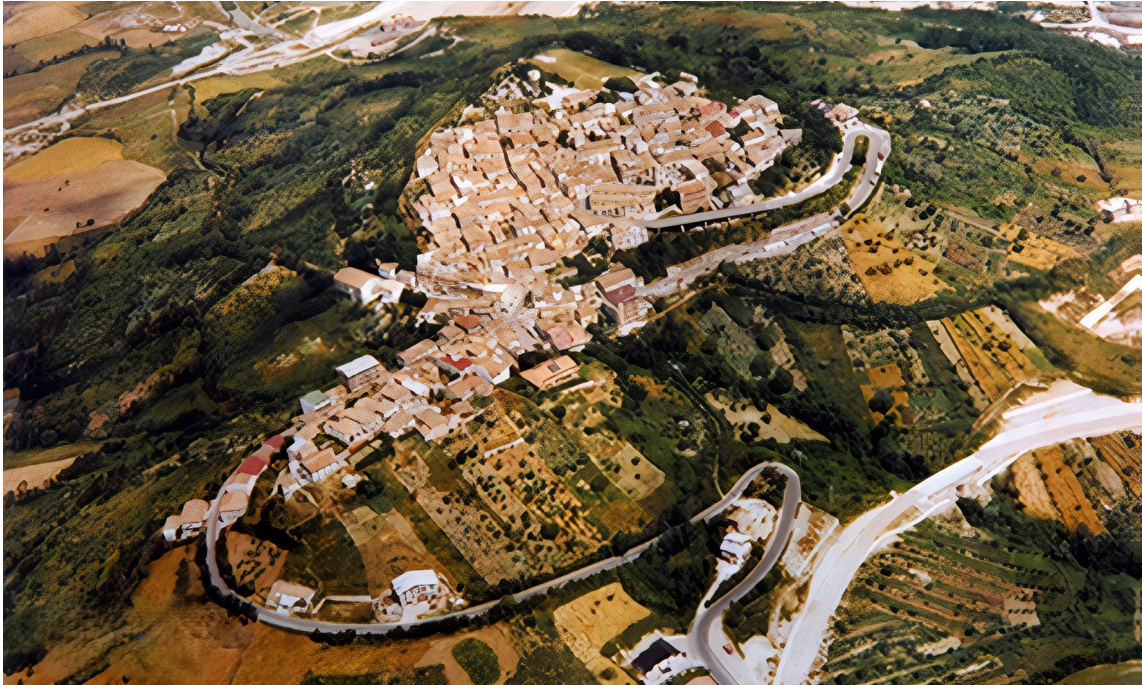
Fig. 1 Veduta di Conza della Campania prima del sisma del 1980
